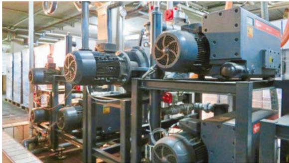
Ein Vakuumsystem von Busch Vacuum Solutions versorgt die Verpackungslinien mit dem benötigten Vakuum
